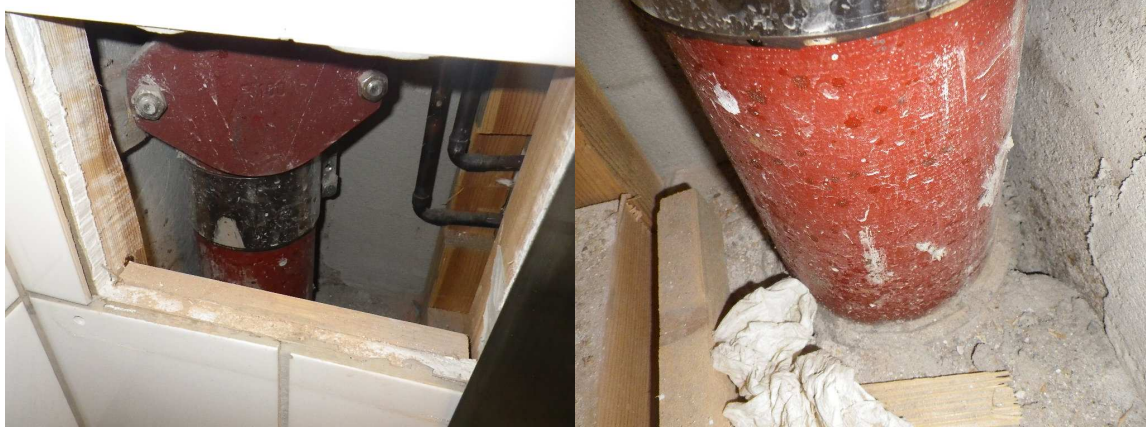
Kuva 25. Pesuhuoneen viemärikotelon tarkastusluukun kautta ei havaittu merkittävää.
