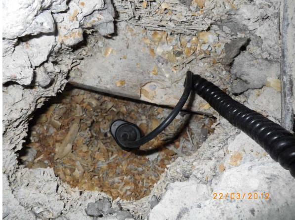
Kuva 20. Yläpohjan palopermanto piikattiin kahdesta kohdasta auki, jotta rakenteen kosteus voitiin mitata ja lämmöneristeestä (kutterinlastusta) ottaa materiaalinäyte
