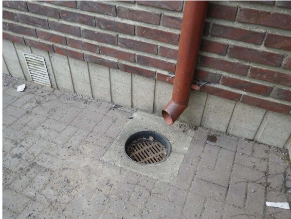
Kuva 5. Yläpihalla katolta tulevat sadevedet laskevat sadevesikaivoihin.
