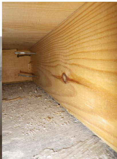
Kuva 35. Kaapin pohjalevyyn tehtiin reikä, josta tarkastettiin kiinteän kaapin pohjan tilannetta. Kaapin alla ei havaittu vaurioita (vasemman puoleinen kuva).
