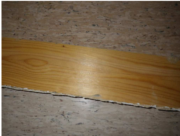
Kuva 37. Irrotetun jalkalistan taustapinnassa ei ollut merkkejä vaurioista.
