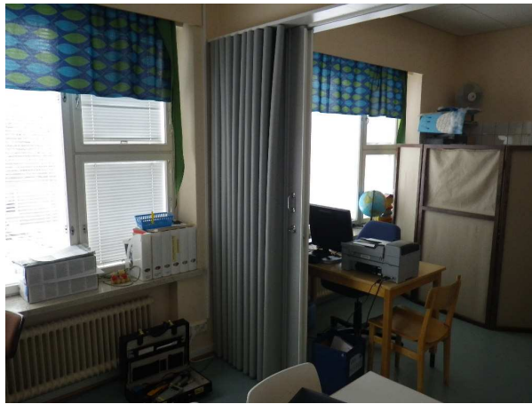
Kuva 40. Tietokonetilan paljeovi haisee.
